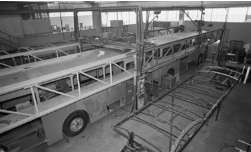
Usine d’assemblage des trolleybus Ramseier 1973. Collection ETH. Libre de droits.
